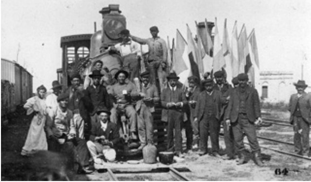
1. Personal del tren, obreros y pobladores en un viaje inaugural en una estación de la línea del FFCC de Santa Fe (ca. 1897), Colección Archivo Fotográfico del Ferrocarril de Santa Fe
