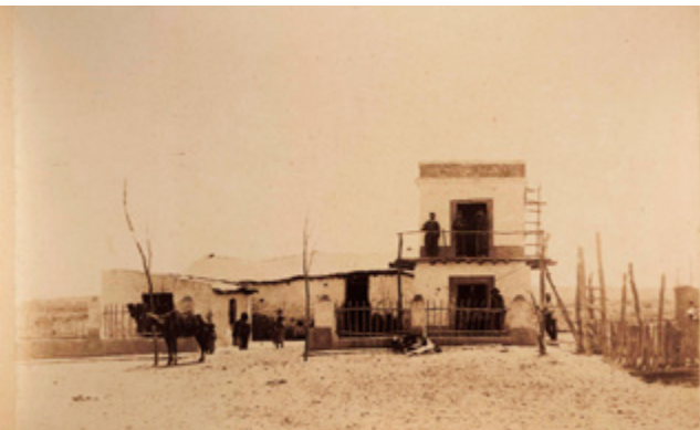
3. Fortín "1a división" sobre la margen izquierda del Neuquén (1883), Colección Museo Roca
